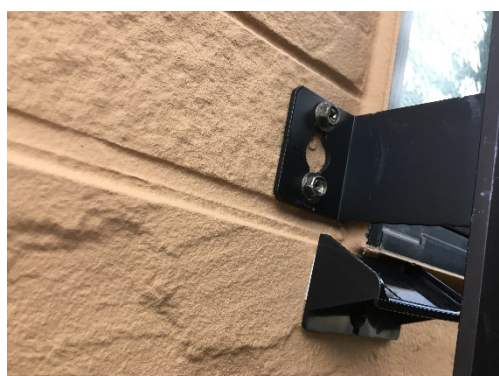
ツタワン施工
