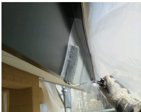
破風板金：錆止めプライマー処理
