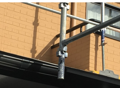
左コーナー部施工
