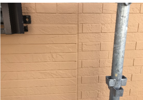
2. サイディング施工
