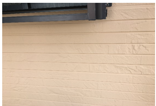
1. サイディング施工
